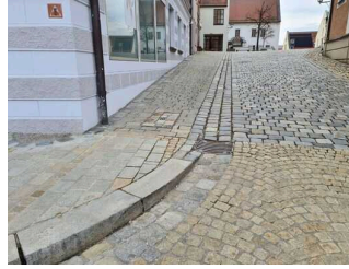
Weg von Haupteingang zu barrierefreien Eingang
