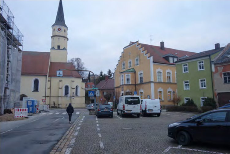
Straßenräume und Quartiersplätze um den Spitalplatz haben das Potential für Aufenthaltsqualität, werden jedoch überwiegend als Parkplätze genutzt
