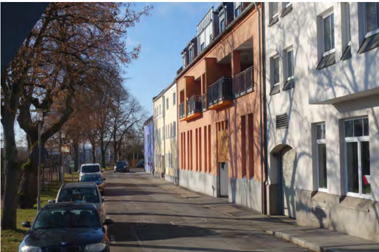
In der Unteren Regenstraße wurde eine Quartiersgarage im Untergeschoss eines Wohnhauses neu errichtet
