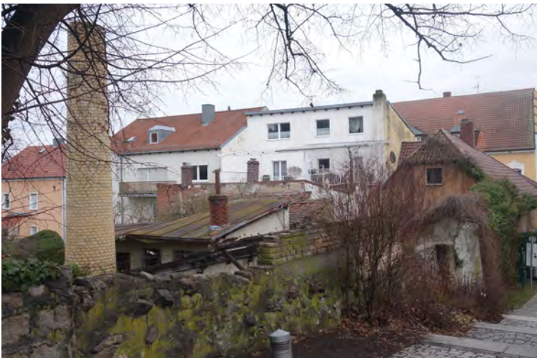
Städtebauliche Missstände im ehemaligen Stadtgraben am Spitalplatz
