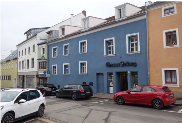
Das denkmalgeschützte „Blaue Haus“ wurde umfassend saniert
