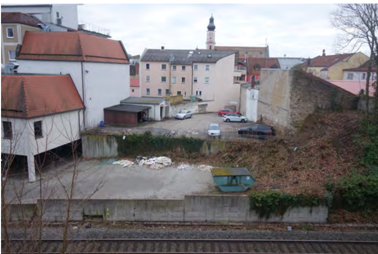
Konzentration von städtebaulichen Missständen im Rückbereich der Randsbergerhofstraße
