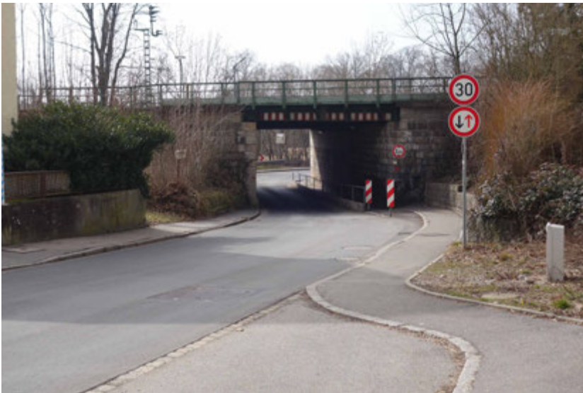
Die Bahnunterführung an der Forstamtstraße stellt mit dem einseitigen, schmalen Gehweg sowie der Querung zum Meranweg einen Mispstand dar
