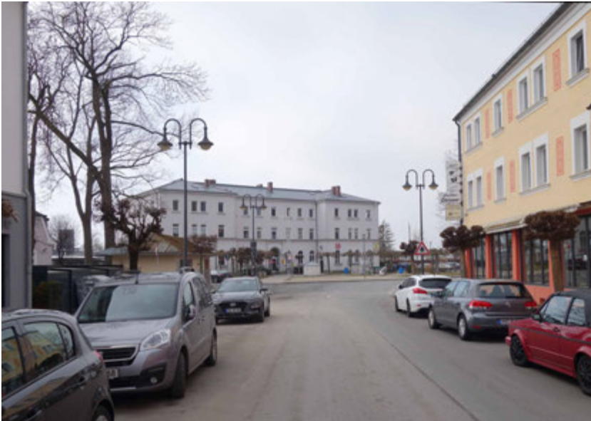
Sichtachse in der Bahnhofstraße auf das historische Stationsgebäude
